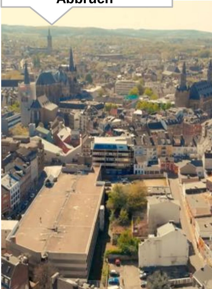
Parkhaus vor dem Abbruch
