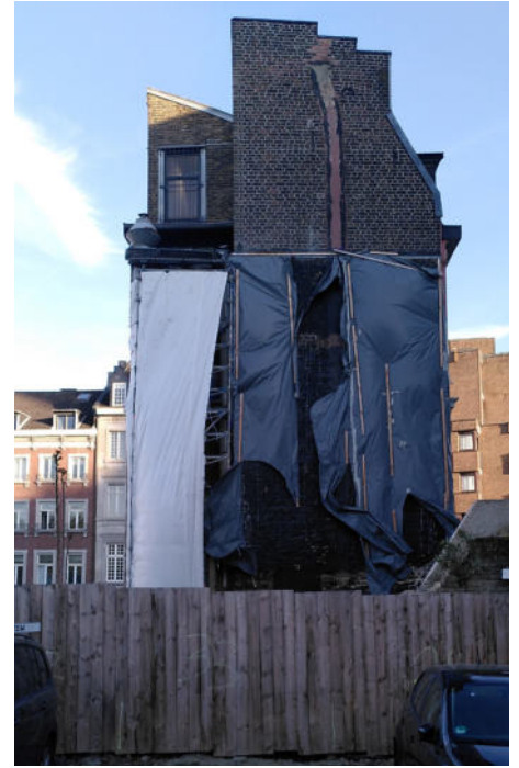
Abb. 22: Nordfassade Nikolausstr. 17 [Foto: weyer gruppe | PROBIOTEC]
