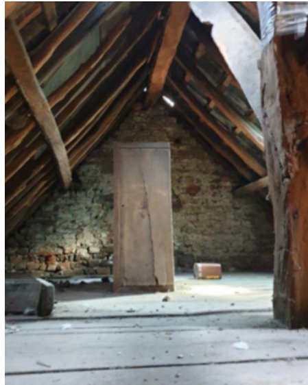
Abb. 16: Spitzboden mit bauzeitlichem Pfettendach [Foto: Stadt SEGA]
