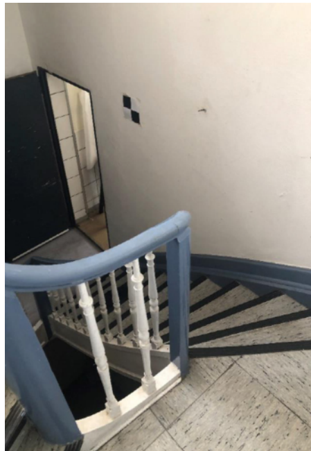
Abb. 24: Historisches Treppenhaus [Foto: M. Knapp]
