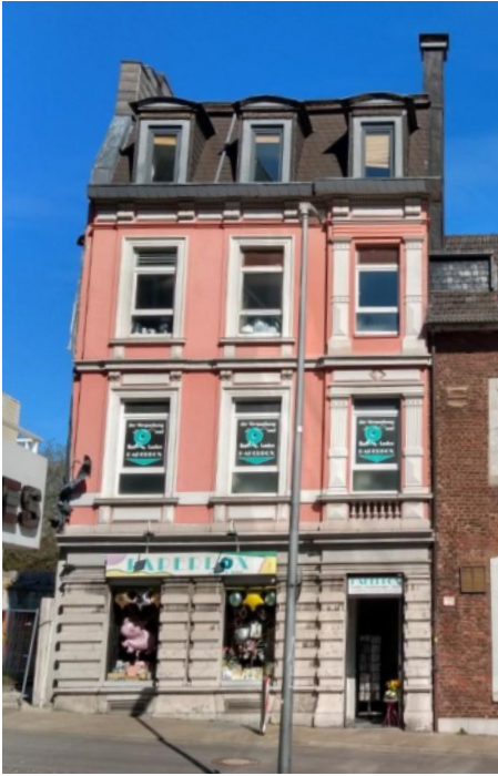
Abb. 20: Nikolausstraße 17, Westfassade [Foto: Stadt Aachen]
