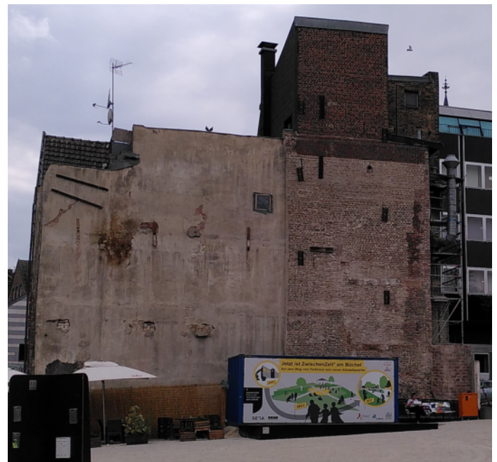
Abb. 4: Ostfassaden nach Abriss des Büchel-Parkhauses 2022; turmartiger Aufbau für das erhöhte Dach über dem Treppenhaus Nikolausstraße 17 [Foto: weyer gruppe | PROBIOTEC]
