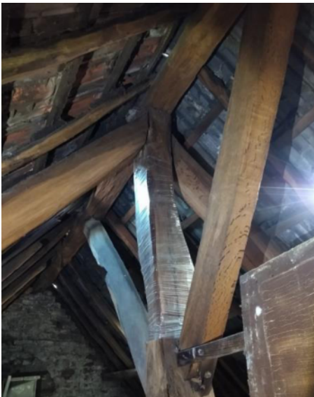
Abb. 18: Spitzboden, Binder Süd [Ab-bund II] [Foto: Stadt Aachen]
