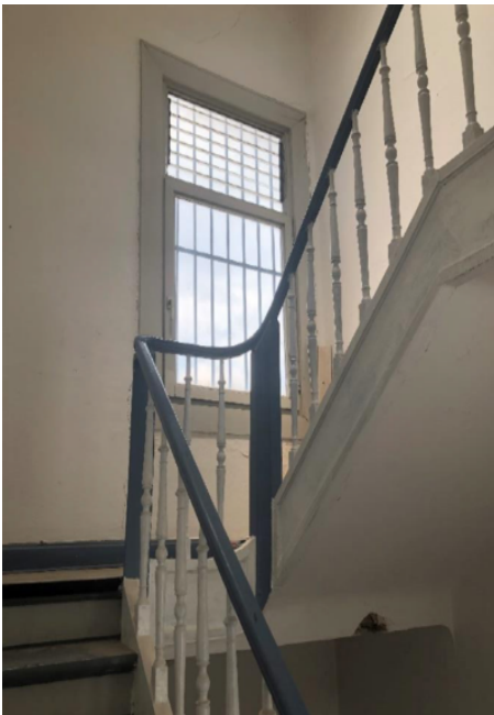
Abb. 23: Historisches Treppenhaus [Foto: M. Knapp]
