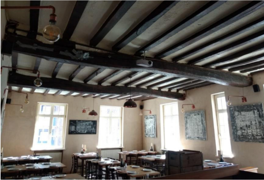
Abb. 13: 1.OG, bauzeitliche Balkendecke mit Mutter- und Kinderbalkenlage [Foto: Stadt Aachen]
