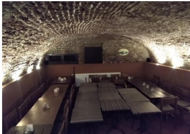
Abb. 8: KG, hist. Gewölbetonne nach Süden, hinten rechts ehem. Kellerhalszugang [Foto: Stadt Aachen]
