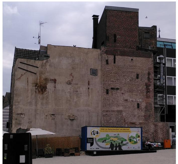
Abb. 4: Ostfassaden nach Abriss des Büchel-Parkhauses 2022; turmartiger Aufbau für das erhöhte Dach über dem Treppenhaus Nikolausstraße 17 [Foto: weyer gruppe | PROBIOTEC]
