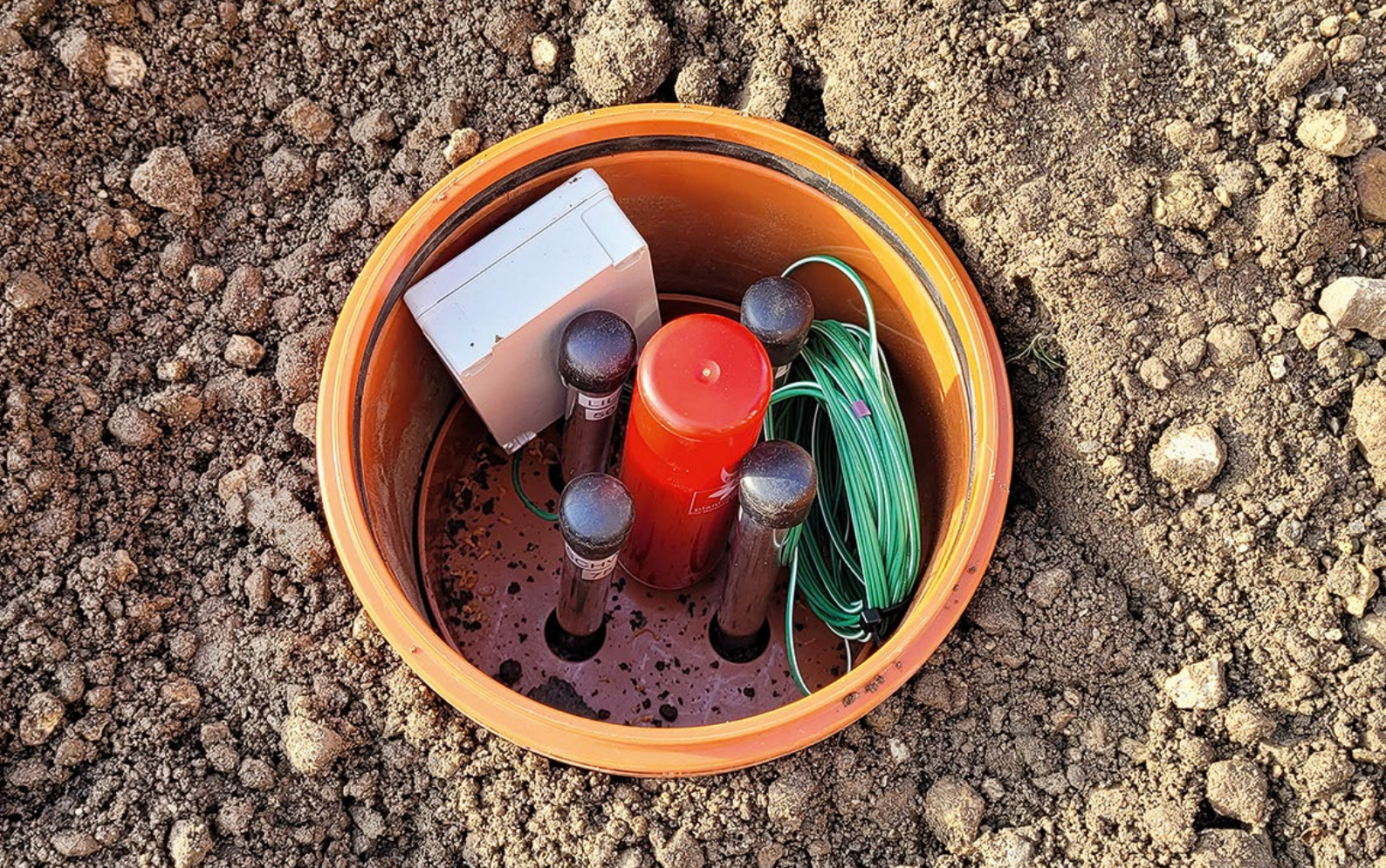
Die eingebauten Sensoren Quelle: co:met GmbH
