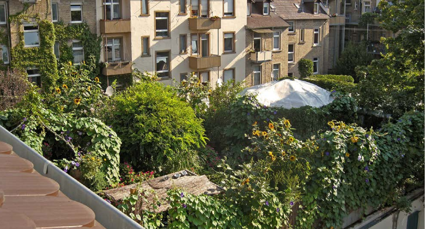
| Begrünte Dachfläche in Karlsruhe Quelle: Stadt Karlsruhe Gartenbauamt, Hildegard Breitenbach-Koch
