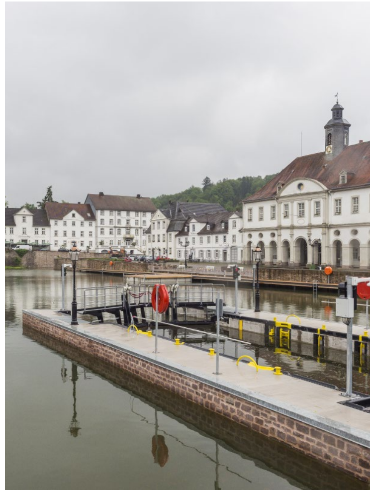
Bad Karlshafen – Wiederaanbindung des historischen Hafens an die Weser. Foto: Lars-Christian Uhlig, BBSR
