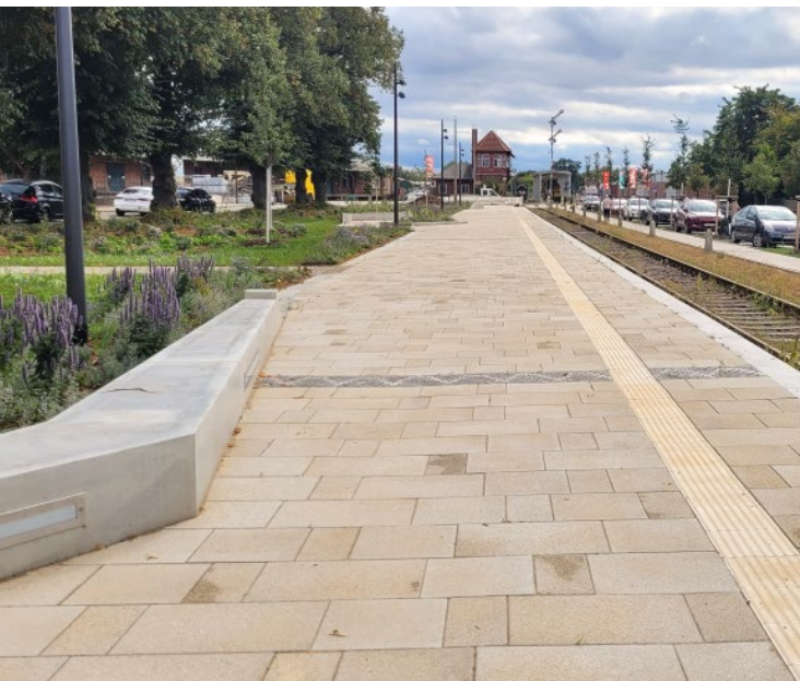
Wittenberge – Blick Richtung Stellwerk am Bahnhof. Foto: Stadtverwaltung Wittenberge, Bauamt 2025
