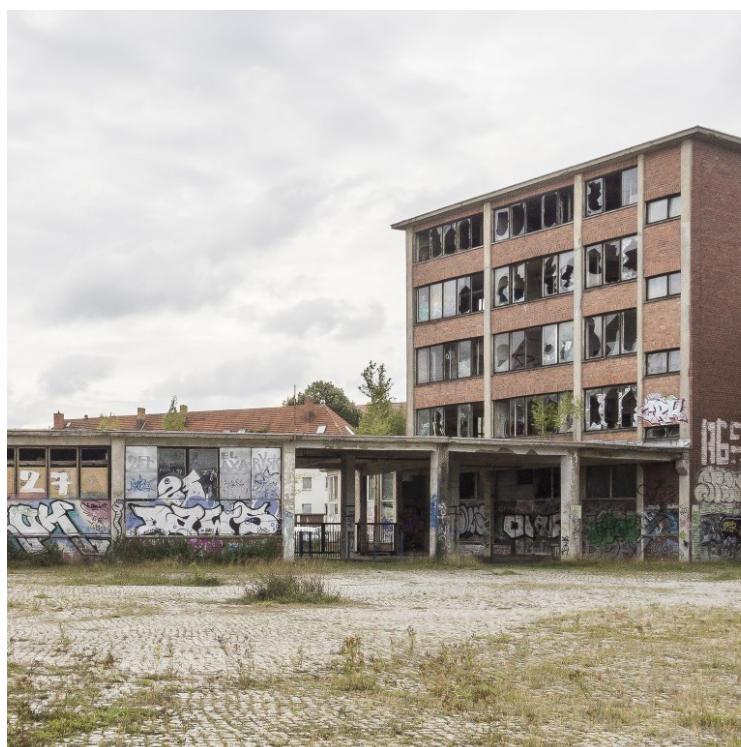
Schwerin – Kraftfahrzeuginstandsetzungswerk. Foto: Lars-Christian Uhlig
