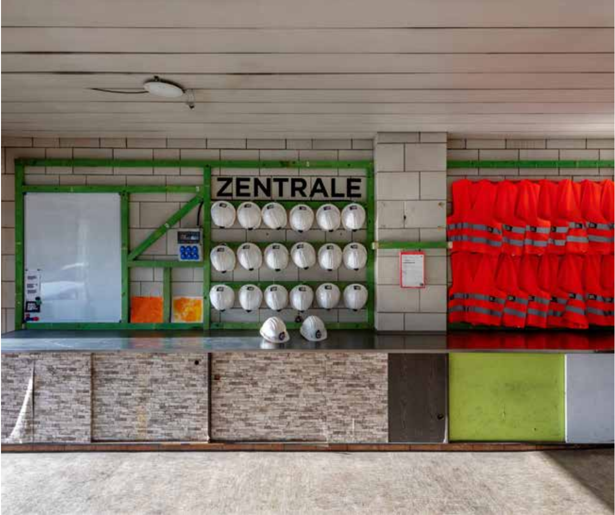
Die Zentrale des UmBauLabors: Grüne Latten wurden aus der ehemaligen Trennwand der alten Ladenlokale wiederverwendet. ©Tania Reinicke
