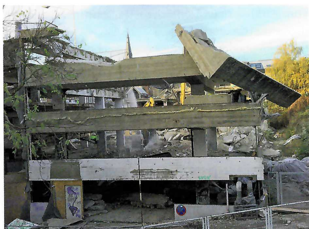
Abbruch Parkhaus Büchel (Foto: SEGA)
